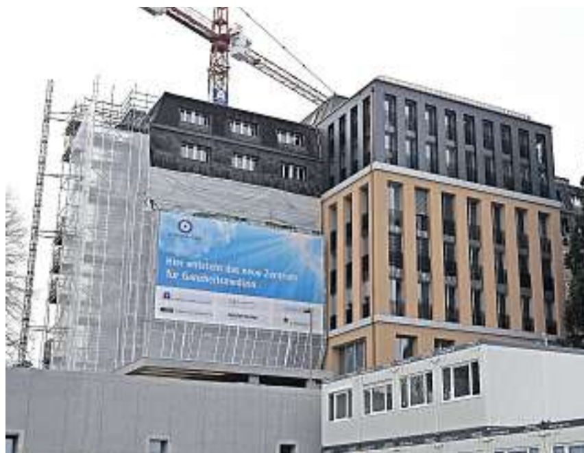
Der Südostflügel: Die Um- und Ausbaurbeiten gehen weiter. Bild Josias Clavadetscher
